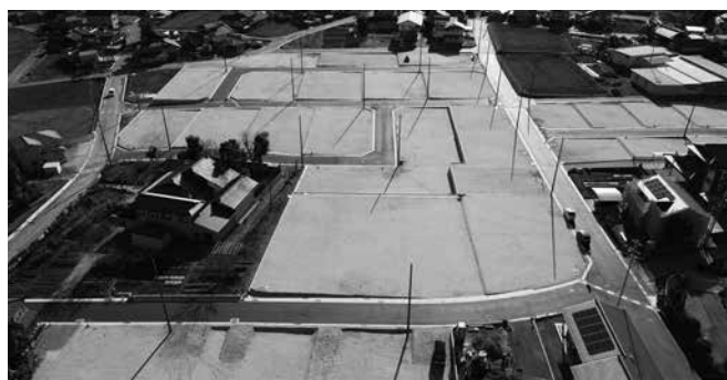
リニア関連 丹保・北条地区代替地整備の様子
